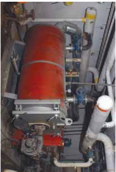
(الف) - د اوبو په واسطه د جریان په طریقې په مرکزګرمۍ کې د تودوخې انتقال
